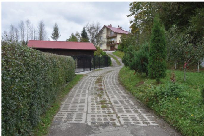
Droga w Przysietnicy przed modernizacją
