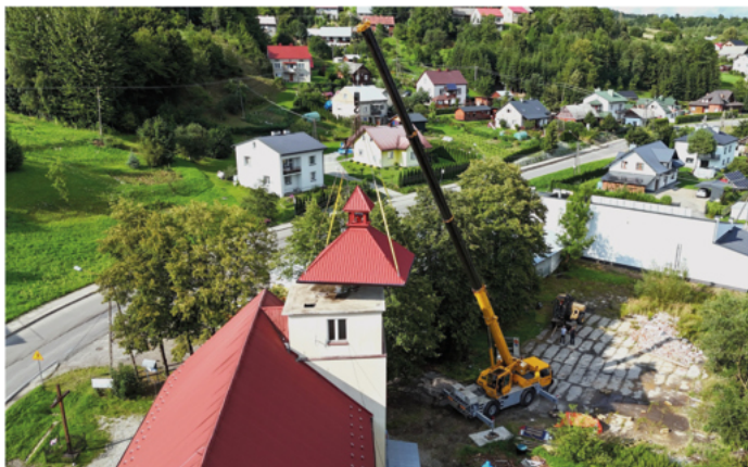
Montaż nowej wieży na budynku OSP
