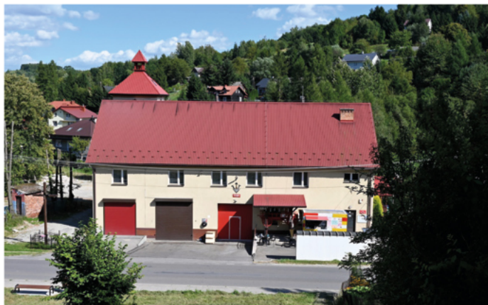
Nowa wieża po zakończonych pracach remontowych
