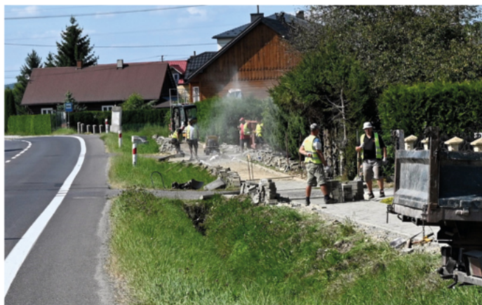
Remont chodnika przy drodze wojewódzkiej nr 886
