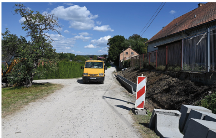
Modernizacja drogi na działce nr 3541/2
