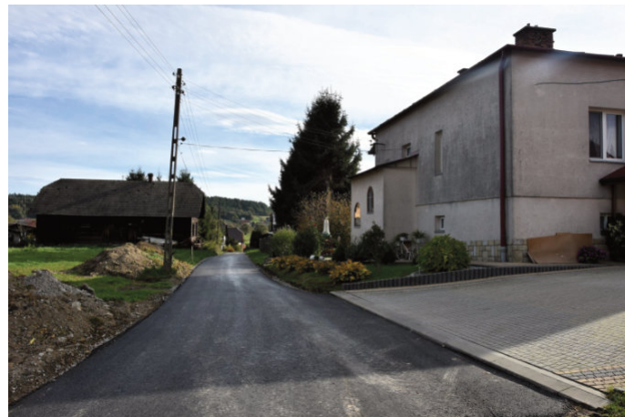
Jedna z przebudowanych dróg w Starej Wsi
